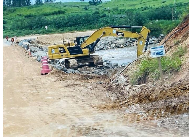
Foto 266 – Manutenção do enrocamento da passagem molhada. (Data:06/01/2023)
