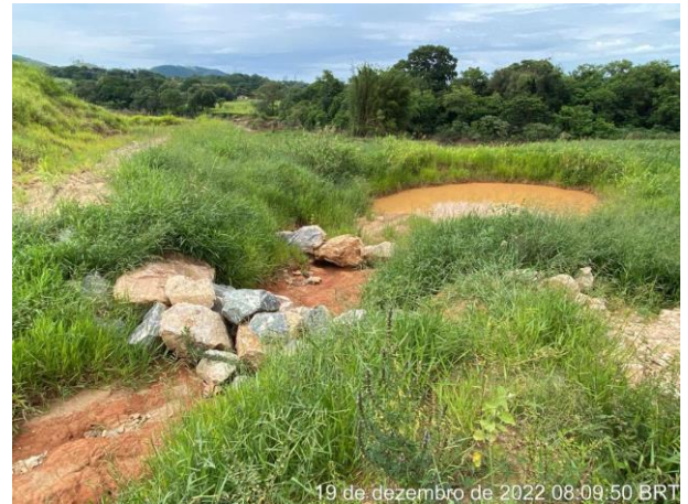
Foto 187 – Vista para as caixas de retenção. (Data: 19/12/2022)
