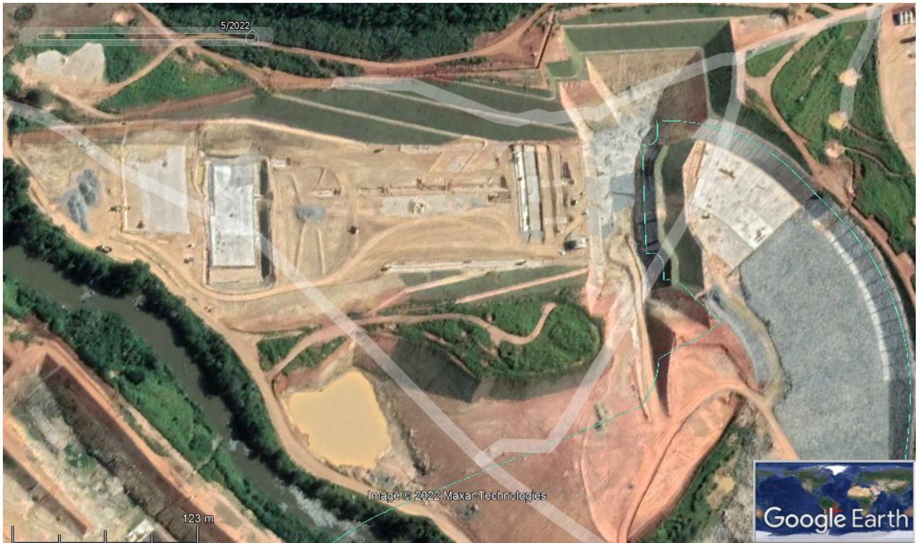
Foto 190 – Margem Direita - Vertedouro. (Ilustrativo)
