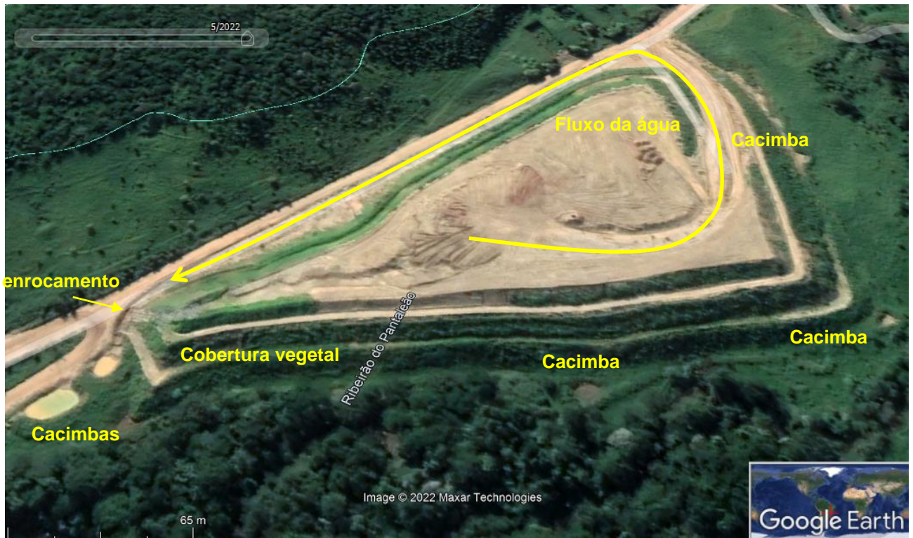
Foto 175 – Bota Fora 2, vista para proteções preventivas em seu entorno.
