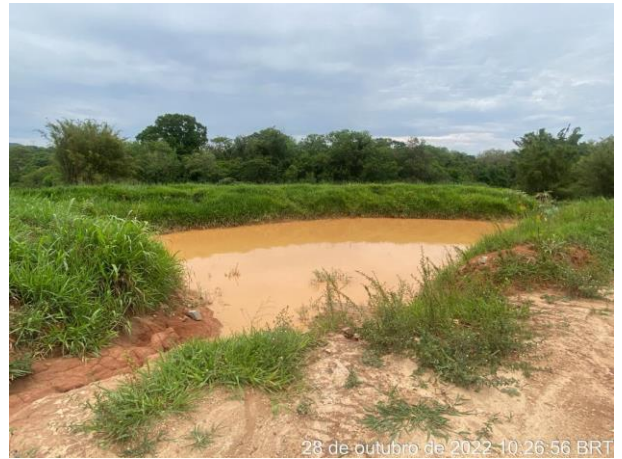
Foto 179 – Cacimba de retenção de sedimento (Data: 28/10/2022)
