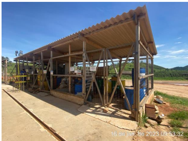
Foto 67 – Baia de produtos Químicos Industrial. (Data:16/01/2023)
