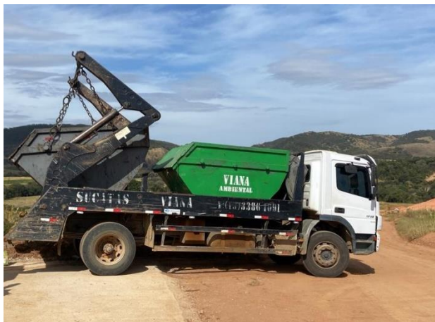
Foto 229 – Troca de caçambas de resíduo comum do canteiro industrial. (Data:09/10/2022)
