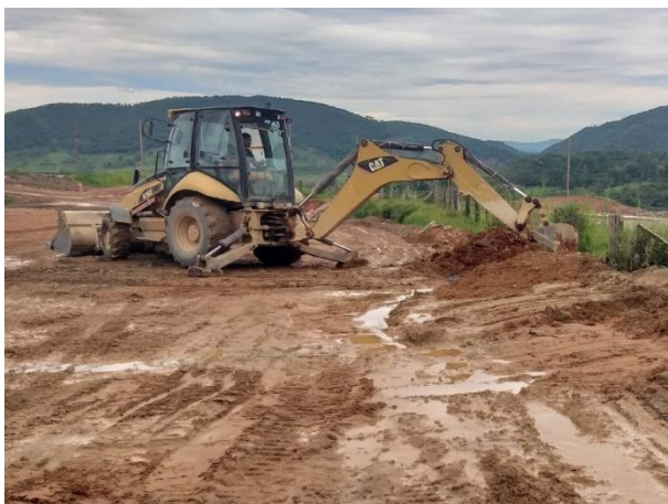
Foto 263 – Movimentação de terra. (Data:17/10/2022)
