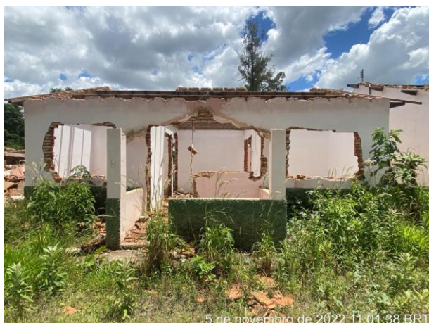
Foto 249 – Demolição da estrutura 29 B, lote 23. (Data:05/11/2022)
