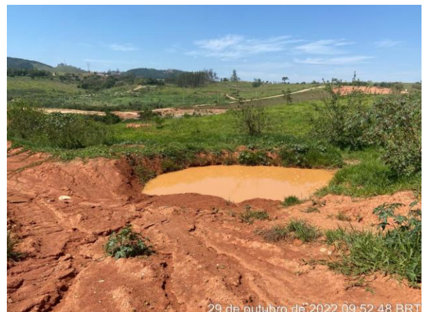
Foto 143 – Vista para cacimba de retenção de sedimento. (Data:29/10/2022)
