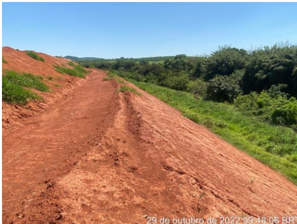
Foto 140 – Vista para leira e inclinação e direcionamento para saia do talude. (Data:29/10/2022)
