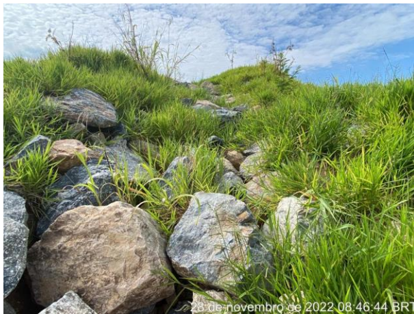
Foto 180 – Enrocamento com disciplinamento do fluxo para as caixas de retenção. (Data: 28/11/2022)
