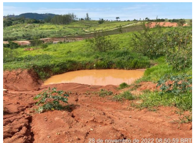
Foto 149 – Vista para cacimba de retenção de sedimento. (Data:28/11/2022)
