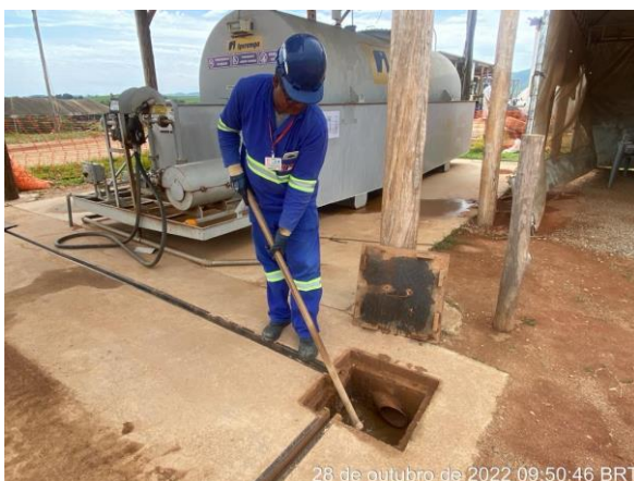
Foto 204 – Manutenção e Limpeza das canaletas e caixa de inspeção na área de abastecimento de combustível. (Data: 28/10/2022)
