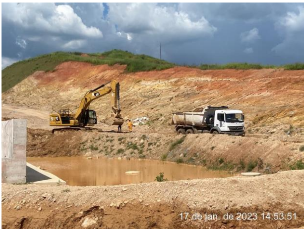
Foto 267 – Movimentação de terra, margem direita. (Data:17/01/2023)
