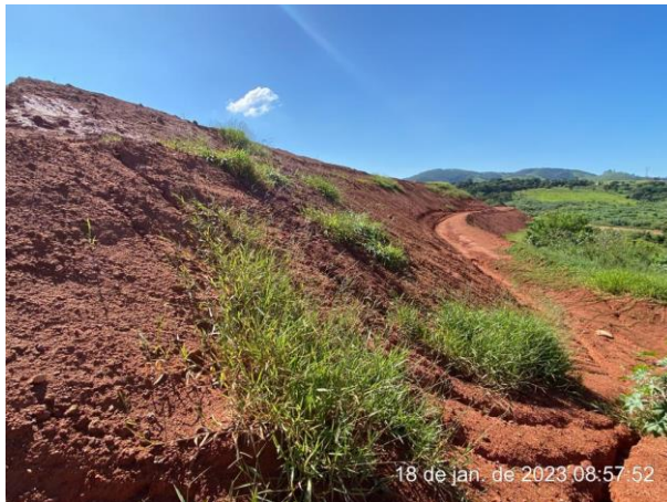
Foto 158 – Vista para leira e inclinação e direcionamento para saída do talude. (Data:18/01/2023)
