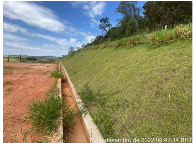
Foto 196 – Grama e canaleta de drenagem. (Data:15/12/2022)
