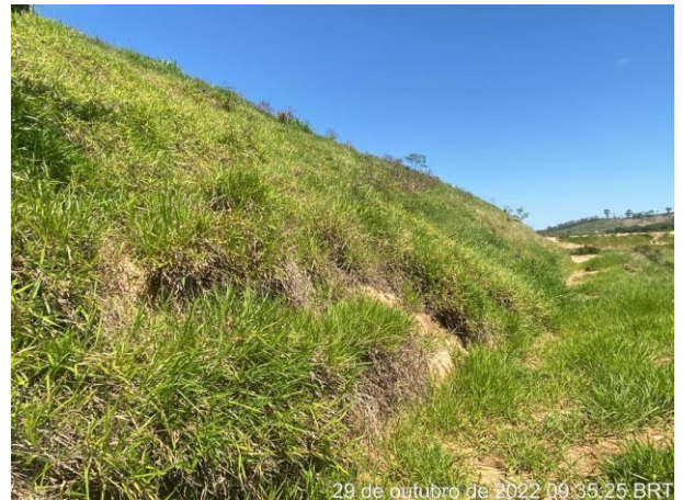
Foto 166 – Vista cobertura vegetal. Bota Fora 01. (Data: 29/10/2022)
