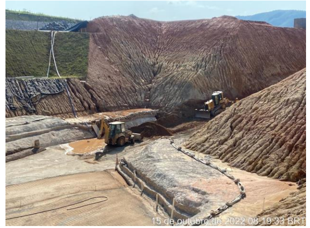
Foto 262 – Movimentação de terra, margem direita. (Data:15/10/2022)
