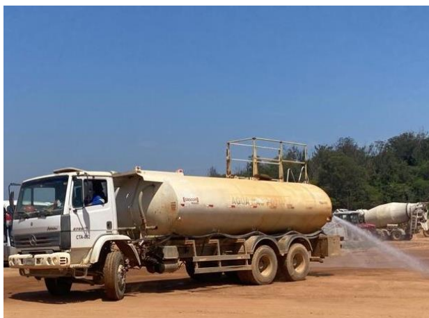
Foto 218 – Umectação de vias interna. (Data:08/12/2022)
