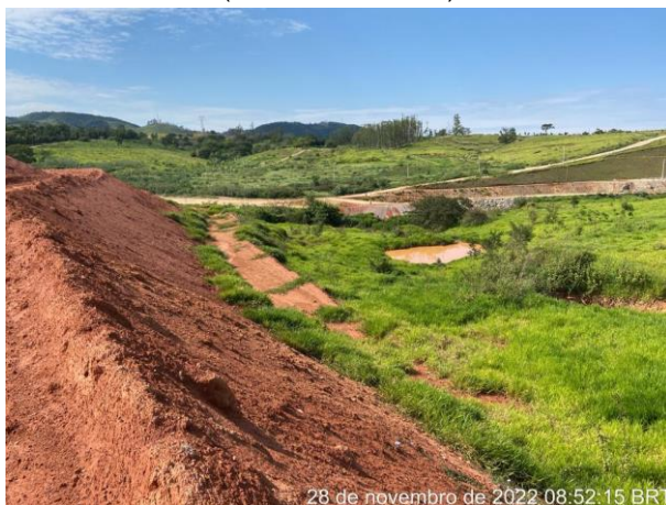
Foto 148 – Vista para cacimba de retenção de sedimento. (Data:28/11/2022)
