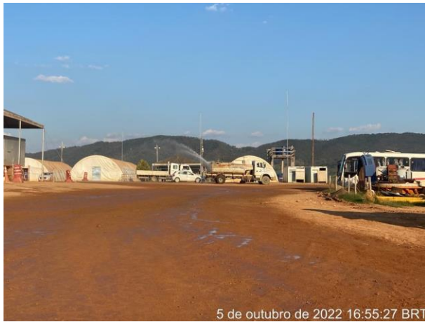
Foto 214 – Umectação de vias interna. (Data:05/10/2022)
