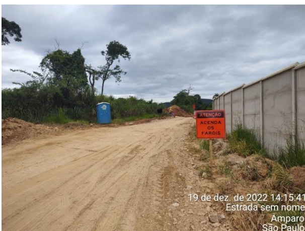
Foto 131 – Sinalização próxima a entrada da obra na via municipal. (Data:19/12/2022)
