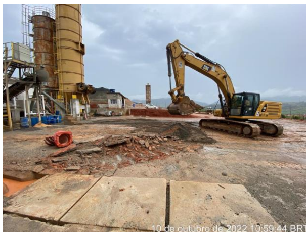
Foto 261 – Movimentação de terra, margem direita. (Data:10/10/2022)
