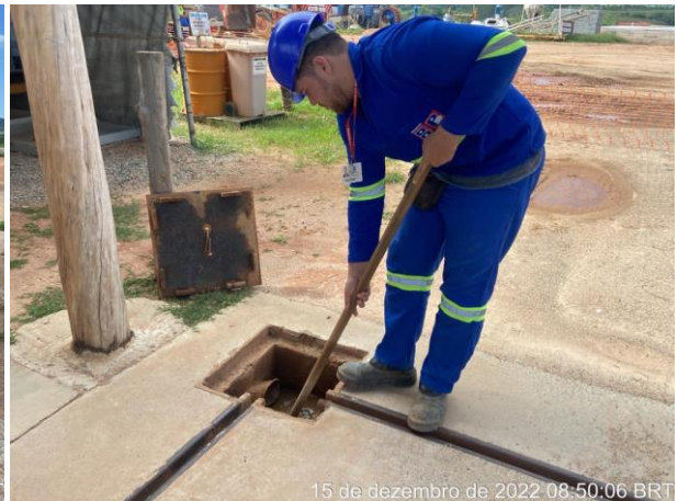
Foto 207 - Vistoria da caixa SAO. (Data: 15/12/2022)
