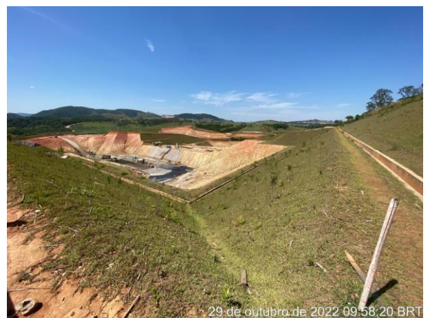
Foto 192 – Grama e canaleta de drenagem. (Data:29/10/2022)
