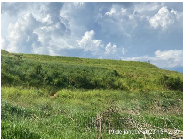
Foto 173 – Vista cobertura vegetal. Bota Fora 01. (Data: 19/01/2023)
