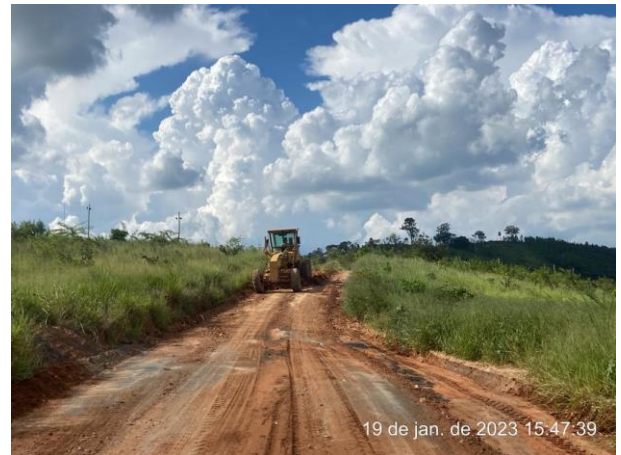
Foto 268 – Movimentação de terra, margem esquerda. (Data:10/01/2023)
