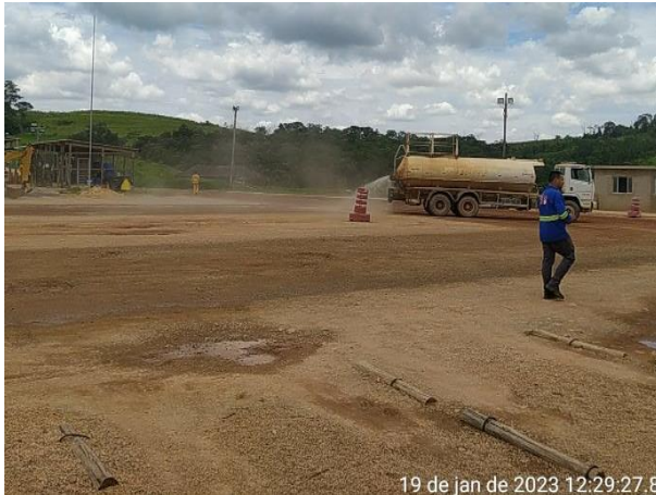
Foto 220 – Umectação de vias interna. (Data:19/01/2023)
