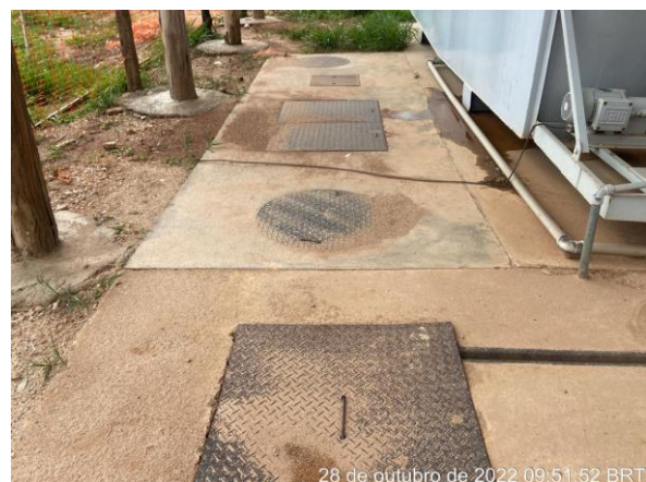
Foto 205 - Vistoria da caixa SAO. (Data: 28/10/2022)
