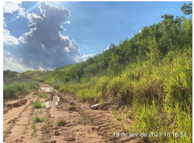
Foto 172 – Disciplinamento do fluxo para as caixas de retenção. Bota Fora 01. (Data: 19/01/2023)
