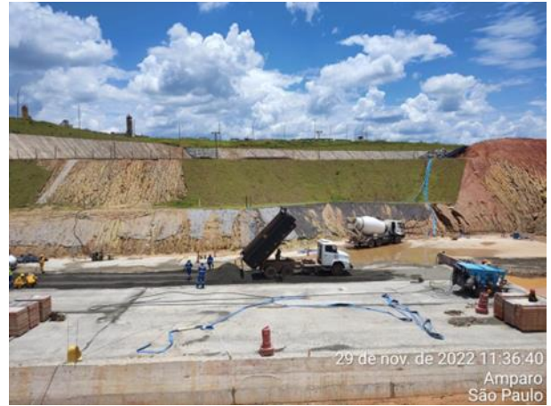
Foto 194 – Grama e canaleta de drenagem. (Data:29/11/2022)
