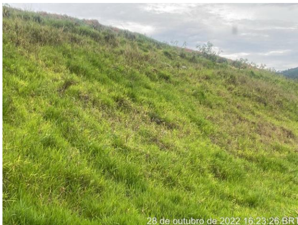
Foto 176 – Talude leira e gramíneas. (Data: 28/10/2022)
