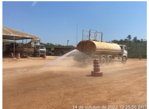
Foto 215 – Umectação de vias internas, Industrial. (Data: 14/10/2022)
