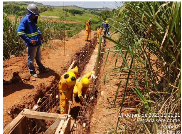
Foto 198 – Grama e canaleta de drenagem. (Data:17/01/2023)
