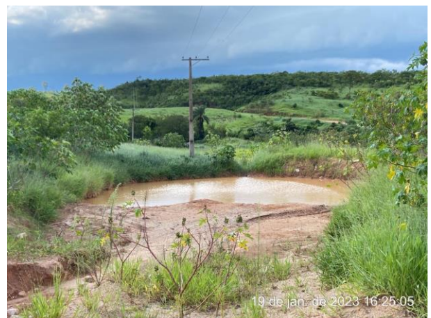
Foto 174 – Disciplinamento do fluxo para as caixas de retenção. (Data: 19/01/2023)
