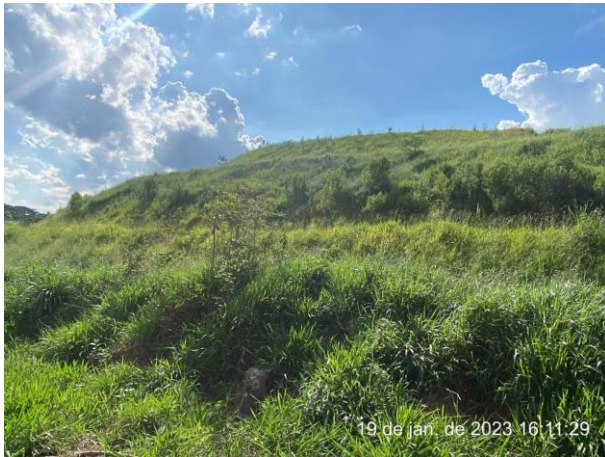
Foto 169 – Vista da cobertura vegetal nos taludes do Bota Fora 01. (Data: 19/01/2023)
