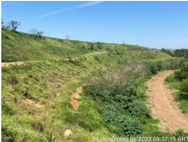
Foto 163 – Vista da cobertura vegetal nos taludes do Bota Fora 01. (Data: 29/10/2022)
