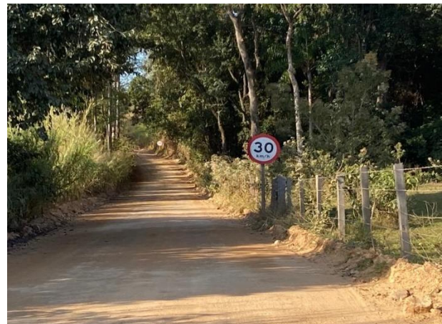
Foto 130 – Sinalização na via municipal de acesso a obra. (Data: 15/11/2022)
