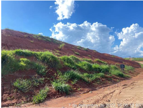
Foto 150 – Leira de proteção no entorno do bota espera com inclinação para a saia do talude. (Data: 07/12/2022)
