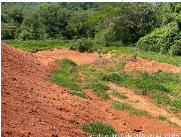
Foto 142 – Vista para cacimba de retenção de sedimento. (Data:29/10/2022)
