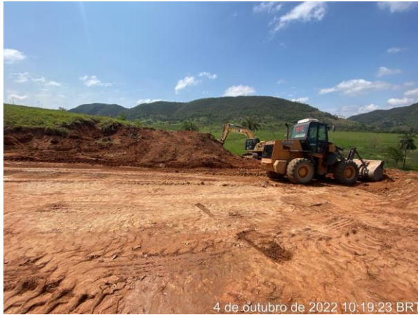
Foto 259 – Movimentação de terra, margem direita. (Data:04/10/2022)
