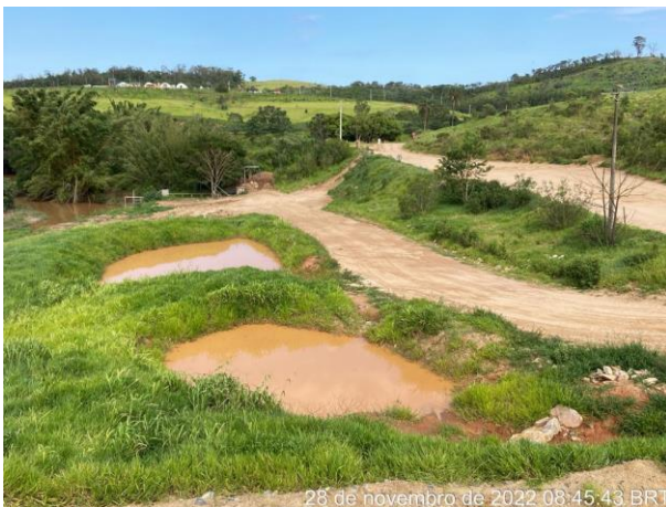
Foto 182 – Cacimba de retenção de sedimento. (Data: 28/11/2022)
