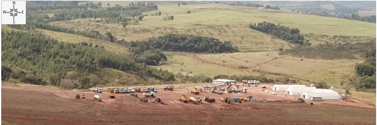
Foto 199 – Canteiro industrial. (Ilustrativo)
