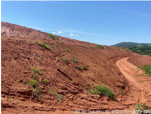
Foto 138 – Leira de proteção no entorno do bota espera com inclinação para a saia do talude. (Data: 29/10/2022)
