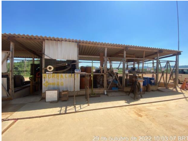
Foto 63 – Baia de resíduos industrial. (Data:29/10/2022)
