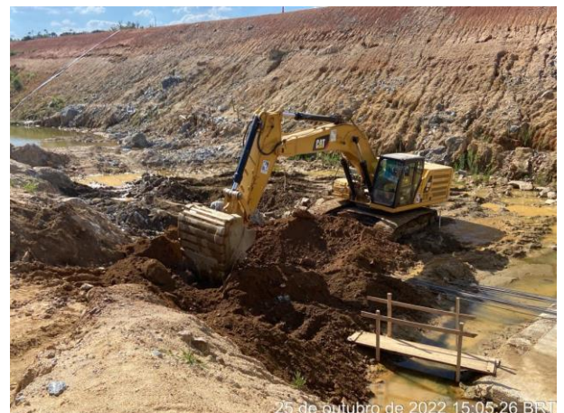
Foto 264 – Movimentação de terra. (Data: 25/10/2022)
