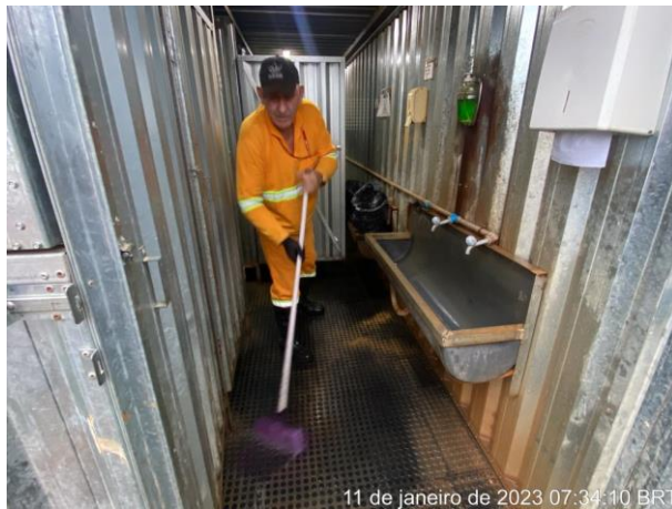
Foto 85 – Limpeza do vestiário. (Data:11/01/2023)
