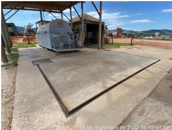
Foto 206 – Canaletas da área de abastecimento limpas. (Data: 15/12/2022)
