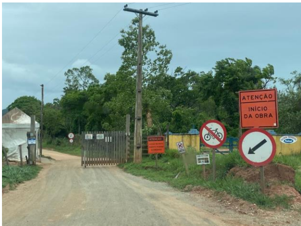
Foto 129 – Sinalização próxima a entrada da obra na via municipal. (Data:13/10/2022)
