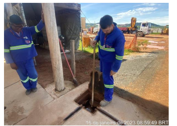
Foto 209 - Vistoria da caixa de inspeção. (Data: 16/01/2023)
