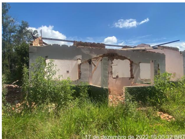
Foto 253 – Demolição da estrutura 29 B, lote 23. (Data:17/12/2022)
