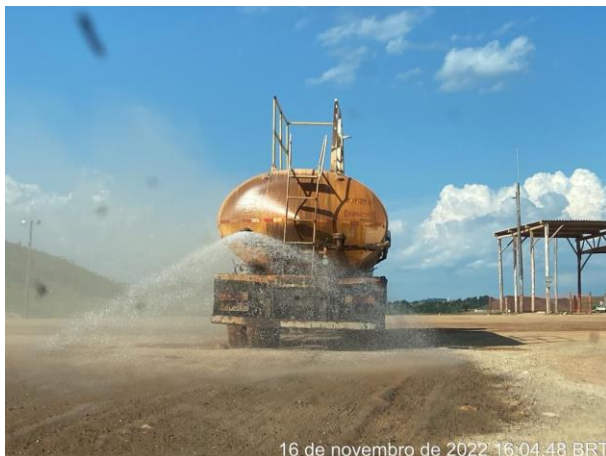
Foto 216 – Umectação de vias interna. (Data:16/11/2022)
