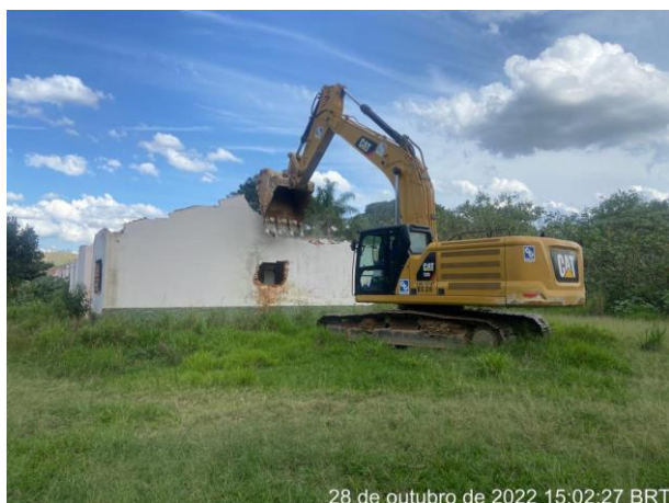
Foto 245 – Demolição da estrutura 29 A, lote 23. (Data:28/10/2022)
