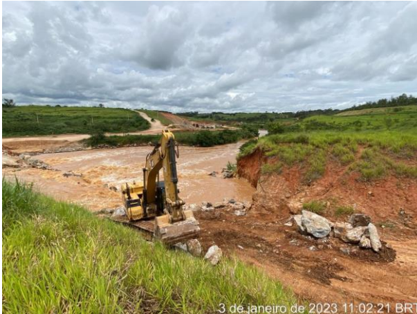
Foto 265 – Manutenção da passagem molhada. (Data:03/01/2023)
