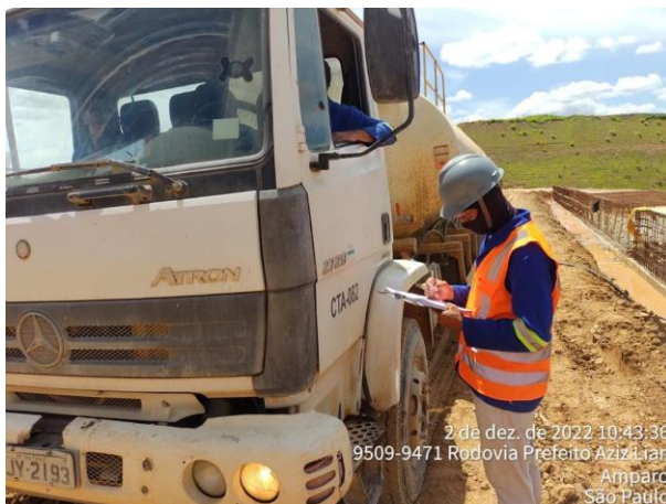
Foto 107 – Inspeção de equipamento realizada pelo auxiliar de segurança. (Data:02/12/2022)
